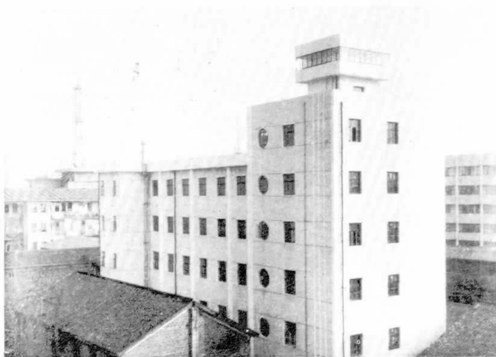
新建的湘乡市邮电局电信楼
