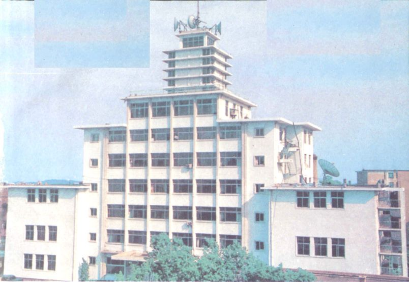
▲青岛市广播电视局办公楼外景。
