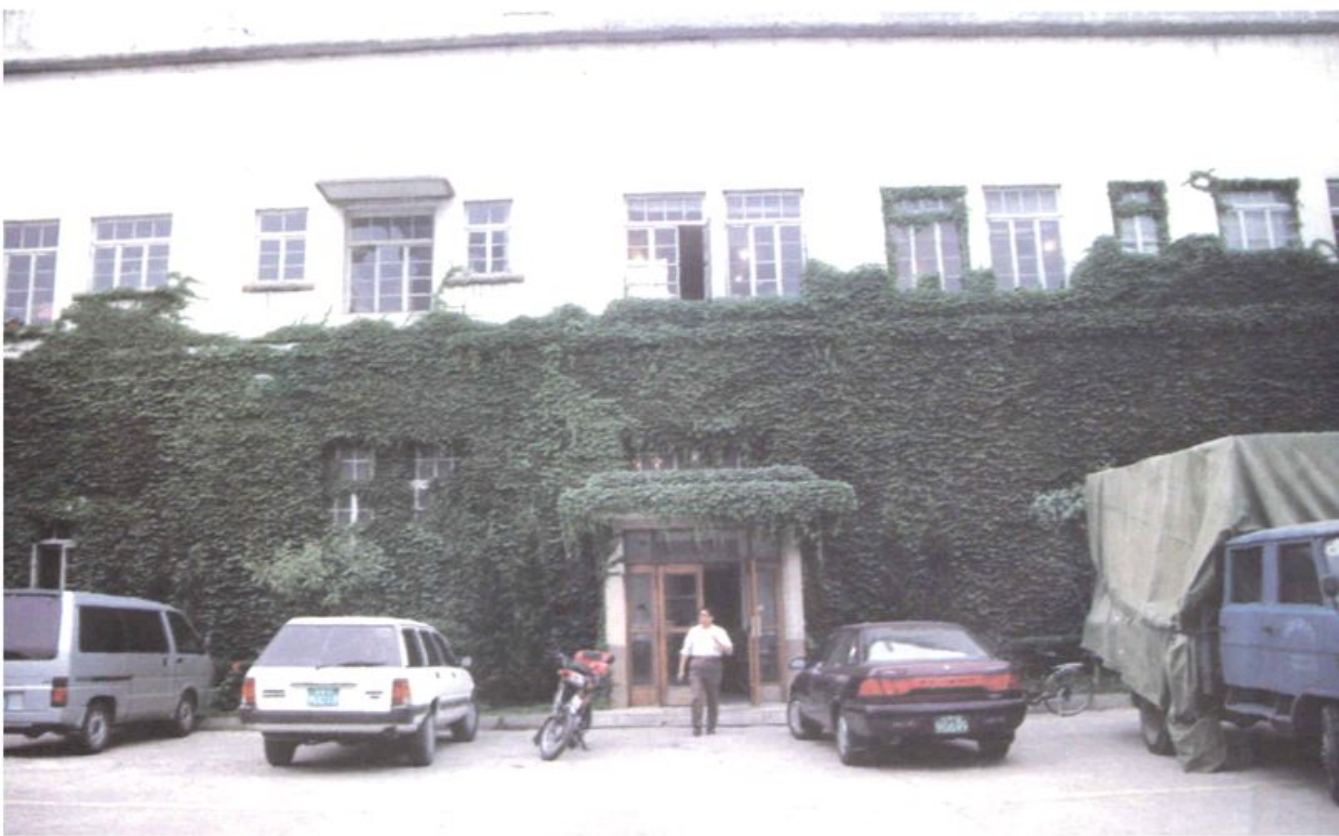
▼1980 年前青岛人民广播电台的技术办公楼东侧面。
