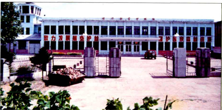
11. 塔河航空护林站塔河镇内办公楼 (塔河航空护林站供稿)
