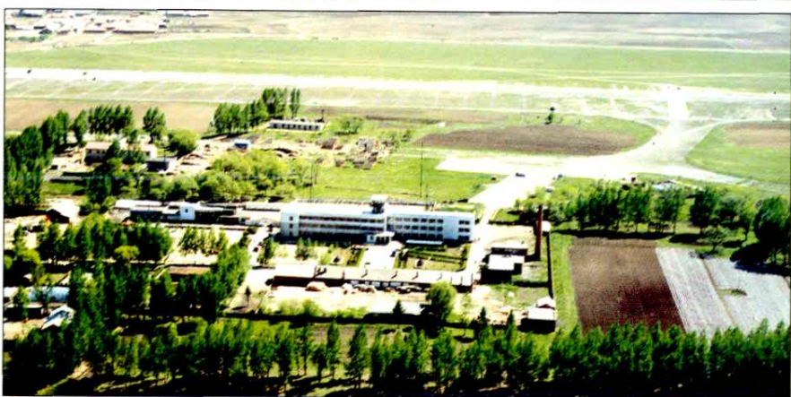
10. 敦化航空护林站机场全景 (敦化航空护林站供稿)
