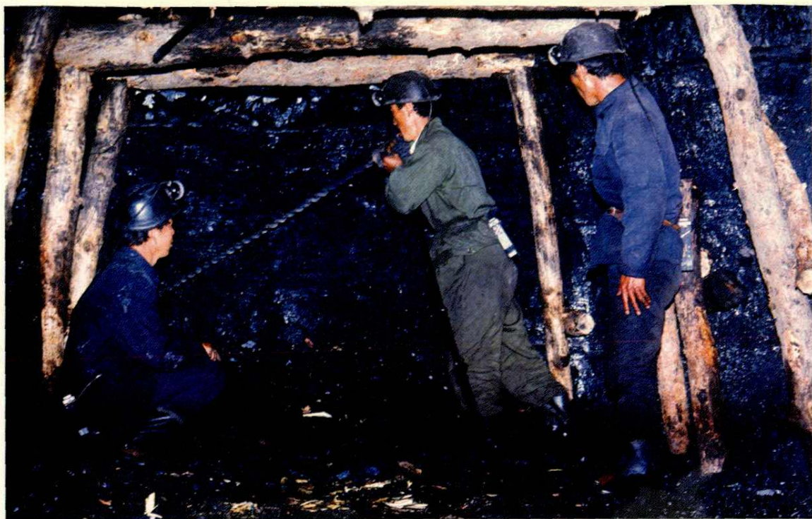
乡镇煤矿掘进工作面
