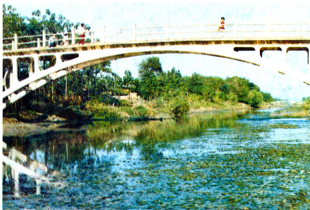
二里大沟 第一桥
