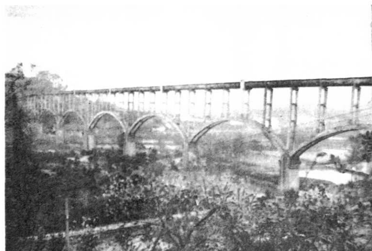
安岳县罗汉寺钢筋混凝土拱梁排架支撑薄壳渡槽
