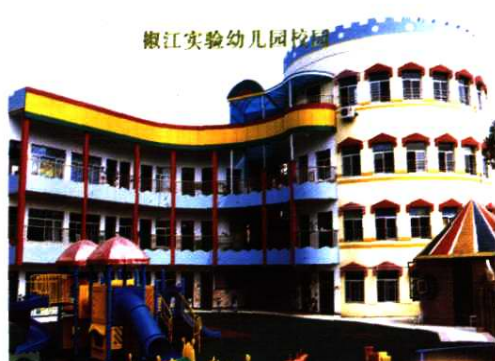
椒江区实验幼儿园(浙江省示范性幼儿园)
