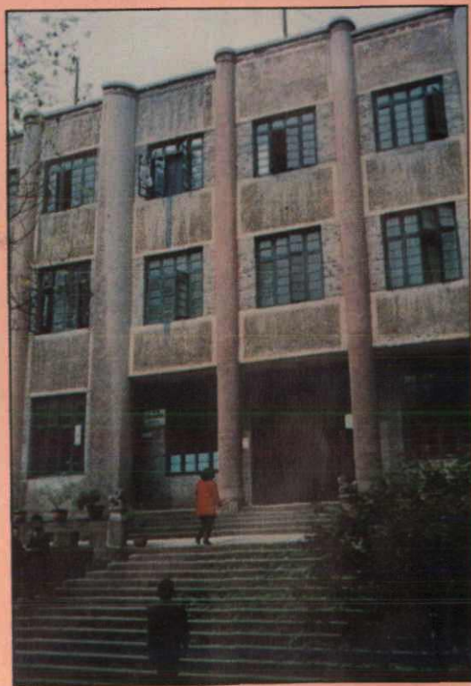
▲ 广安县人民政府办公楼一角
