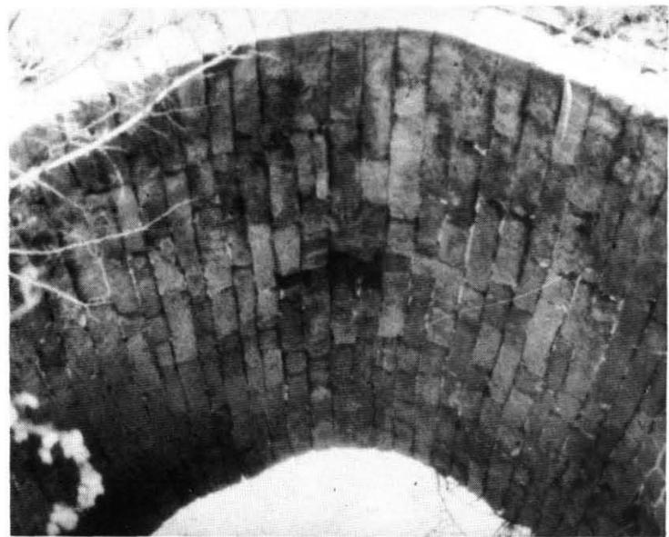
元代通京大道单孔石拱桥——放马桥，此桥面底部为拱圈块石结构。
