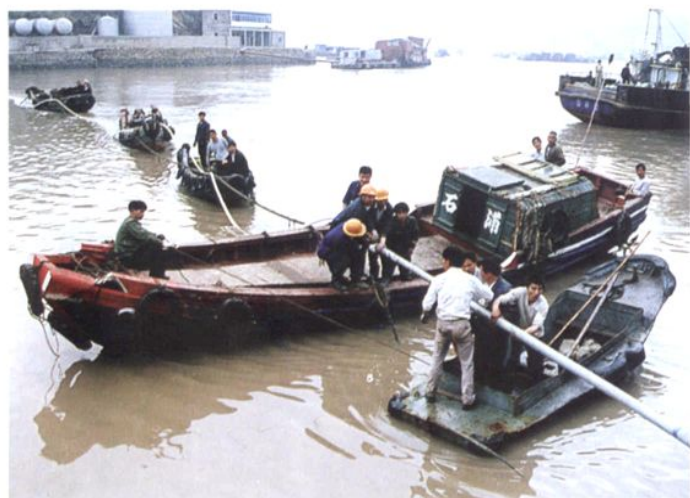
敷设海底电缆
