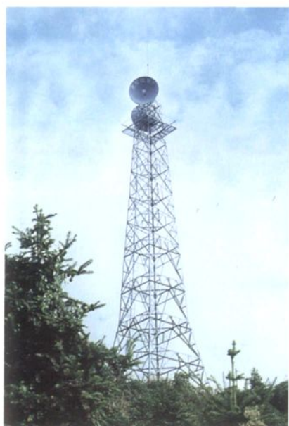
沙地岗微波铁塔
