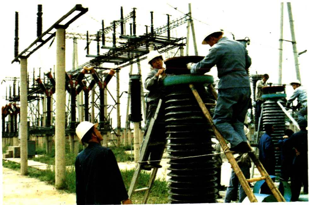
220千伏变电站检修
