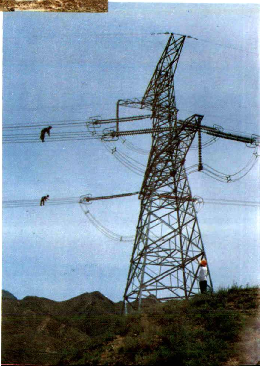
500千伏线路检修
