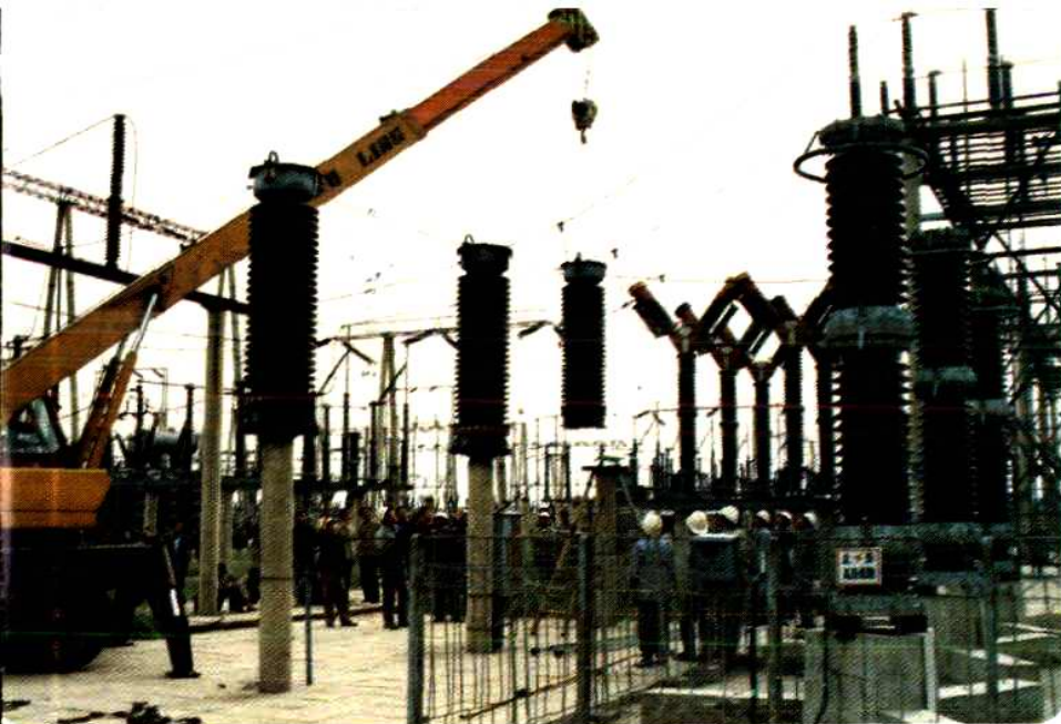
220千伏变电站安装
