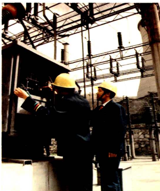
▲ 电气运行人员检查110kw升压站开关运行情况
