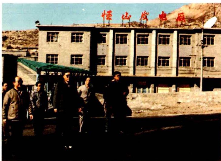
▲ 山西省电力工业局局长卞学海（前排中）来厂视察地震灾情慰问职工
