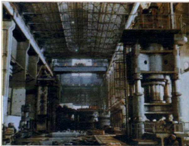
二重厂某车间钢结构厂房之二
