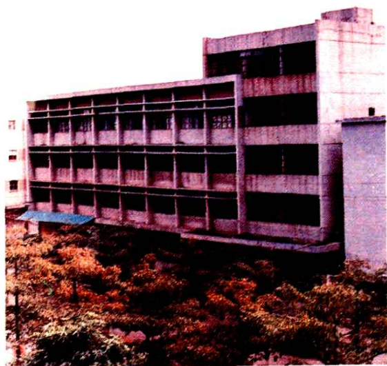
梅县市粮食局办公大楼
