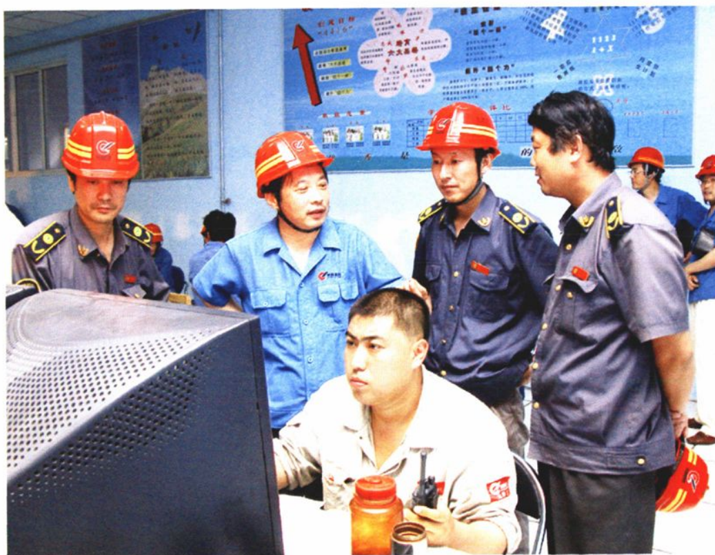
2004年7月2日，自动化部主任栾鲁民（左二）、党委书记郭维河（右二）在大型H型钢生产线建设工地了解自动化工程建设情况。
