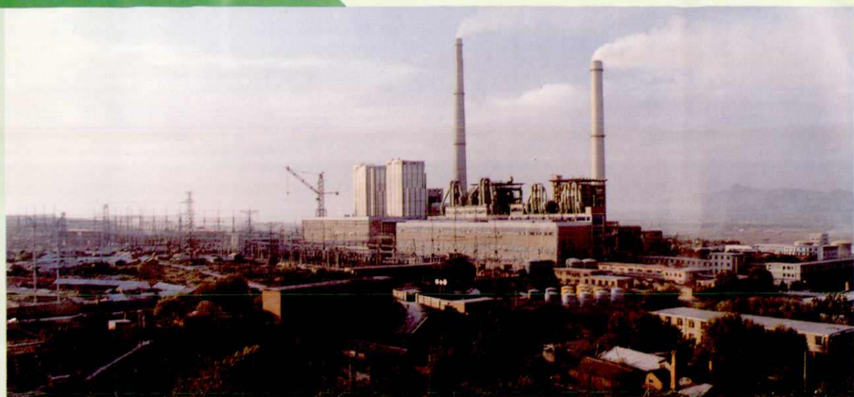
河南省最大的火力发电厂——姚孟电厂（装机容量120万千瓦）
