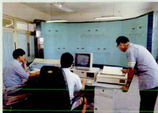
县级电力调度——温县电业局调度室
