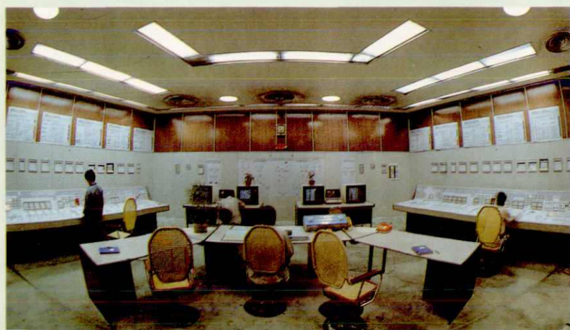
姚孟电厂30万千瓦汽轮发电机组集中控制室
