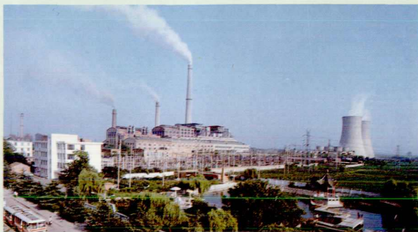
安阳电厂 (装机容量 34 万千瓦)
