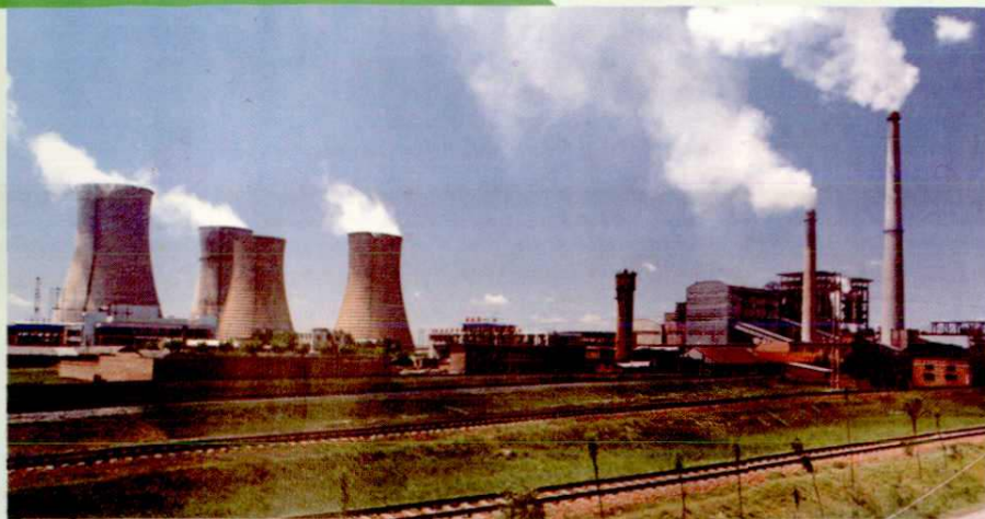
开封火电厂 (装机容量 33 万千瓦)
