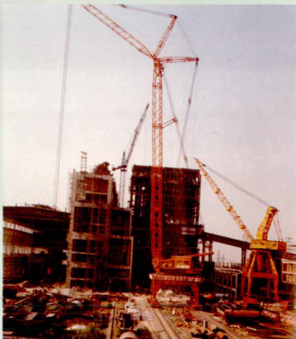
新乡火电厂扩建工程
