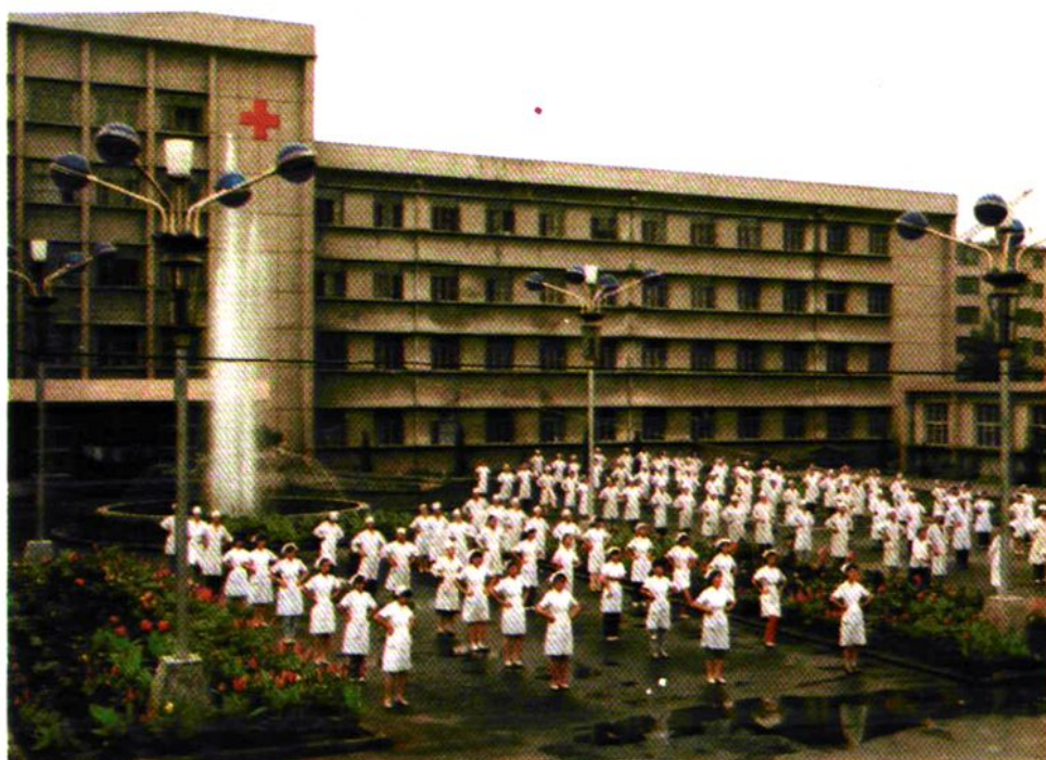
医院门诊部、医技科室楼，四层为干部病房；
