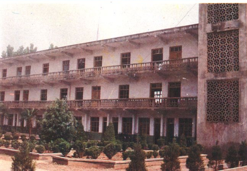
新建的总场中学
