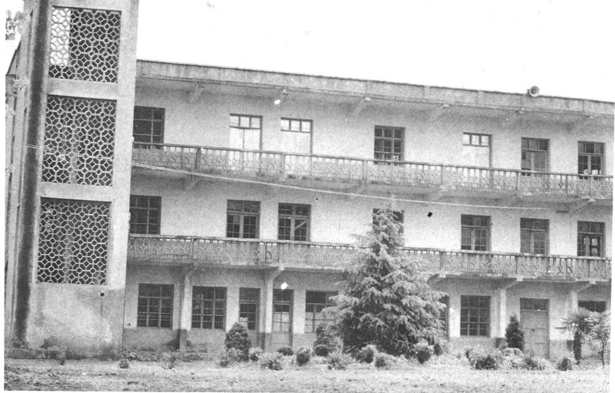
新建的教育大楼
