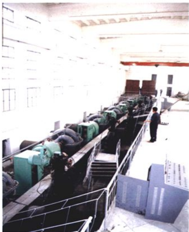
湖水东调工程石墙扬水站机房
