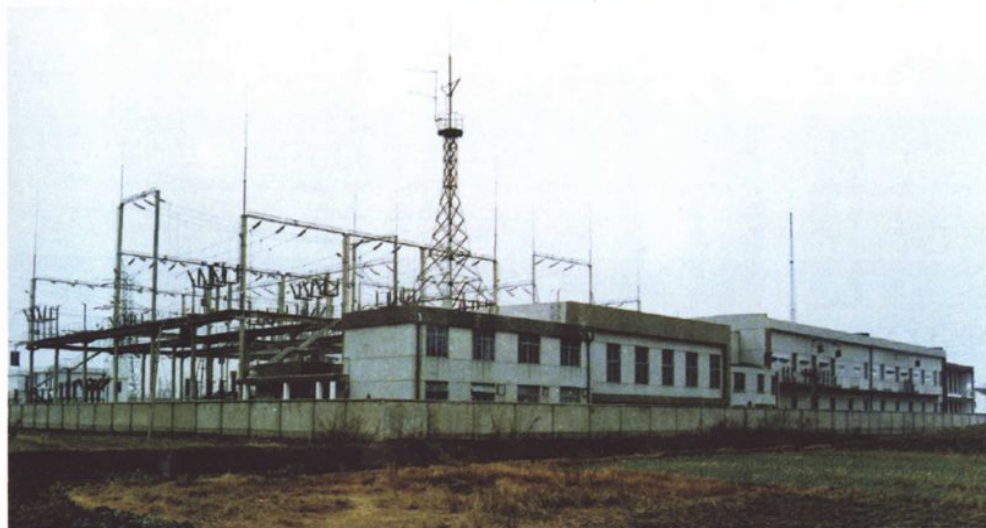
江苏院 1989年设计 完成的220 千伏张家港 港区变电所 工程, 获 1992年度国 家优秀工程 设计铜奖
