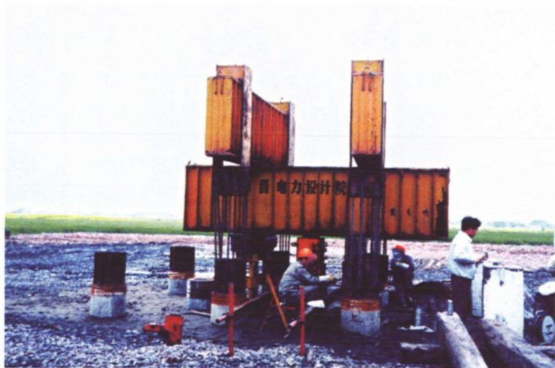
江苏院在华能苏州发电厂工地进行桩基静载荷试验 (1997年4月)
