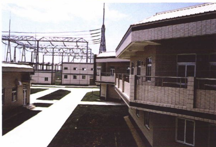
江苏院与华东电力设 计院 2000 年 11 月合作设计 完成的 500 千伏苏州车坊 （胜浦）变电所工程（安装 有国内首次投运的 100 万 千伏安主变压器），2005 年 获第十一届全国优秀工程 设计铜奖
