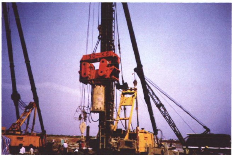
江苏院承揽的镇江电厂试桩工程总承包项目工地 (1998年9月)
