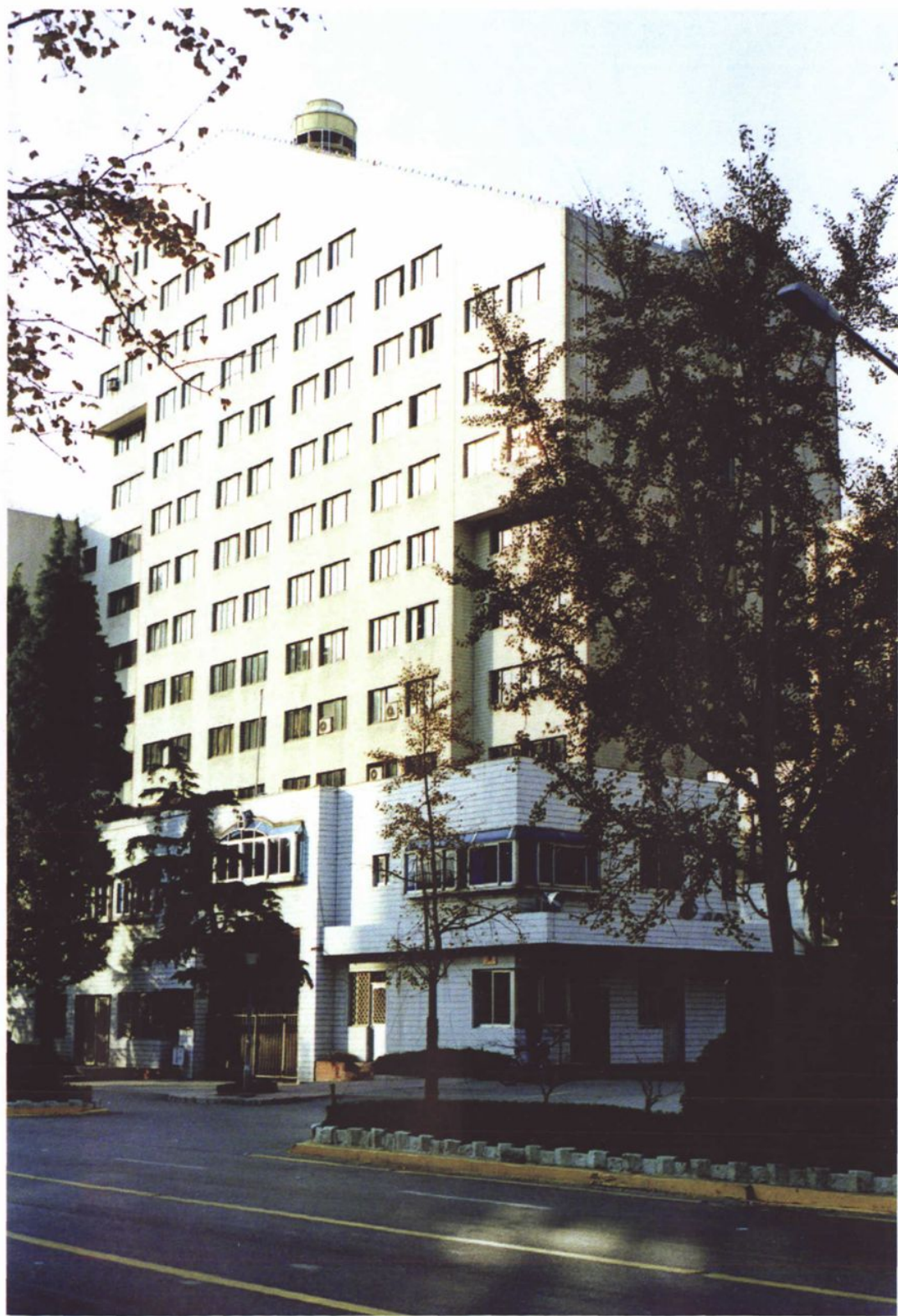
位于南京市北京西路 22 号的江苏院生产办公大楼
