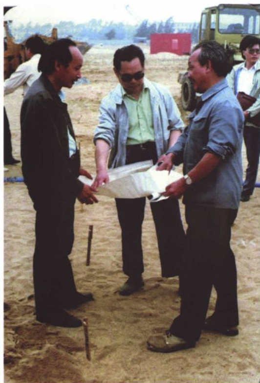
江苏院工程技术人员在广东湛江电厂(2台30万千瓦机组) 振动碎石桩加固地基工程施工监理现场(1991年)
