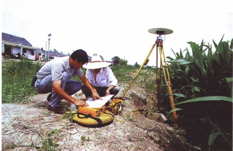
江苏院勘测人员运用全球定位系统 (GPS) 进行500千伏线路测量 (1998年)
