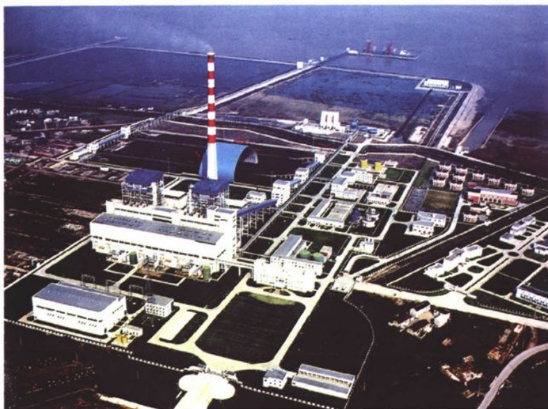
江苏院 1998 年 12 月完成设计的华能苏州发电厂首期 2 台 30 万千瓦机组工程, 2003 年获第十届全国优秀工程设计金奖和第八届全国优秀工程勘察银奖
