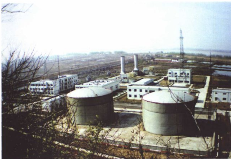
江苏院 1996 年 9 月完成设计的南京高达新港燃机电厂工程 (2 套 3.8 万千瓦单循环燃机机组)
