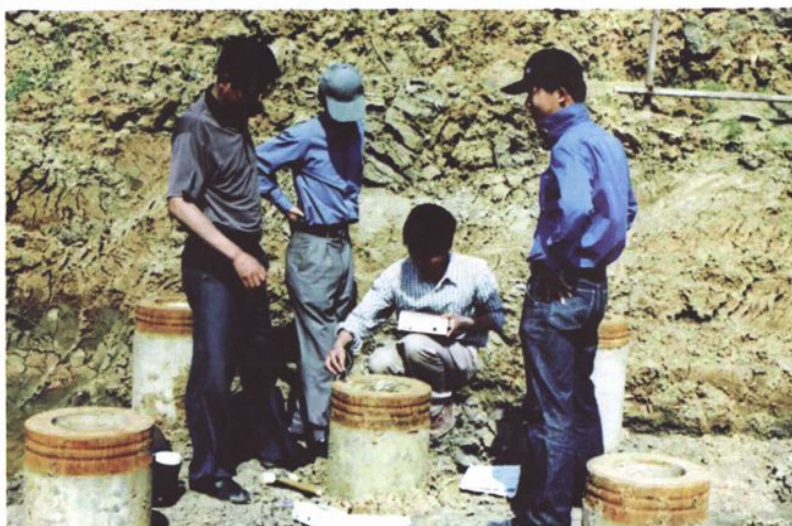
江苏院勘测人员在南京颐和和美地住房工程工地进行桩基检测(2001年)
