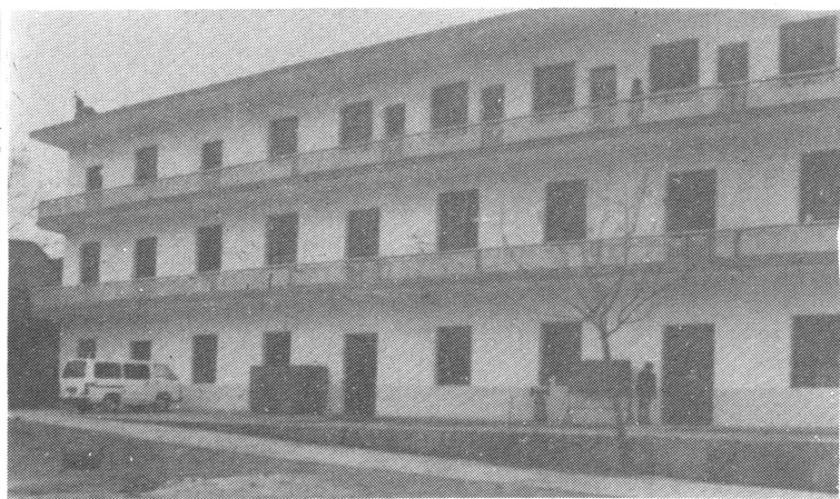
△ 望城县电器开关厂办公大楼
