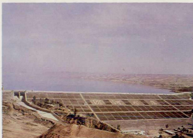
采用水中倒土筑坝 技术的汾河水库大坝
