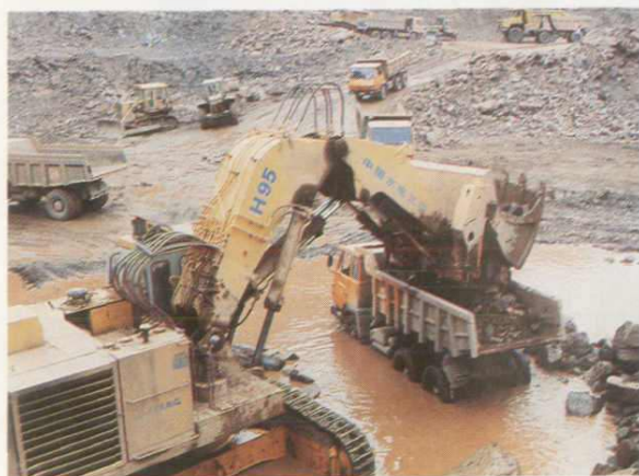
小浪底水利枢纽泄洪工程消 力塘开挖施工景象 刘凤翔摄
