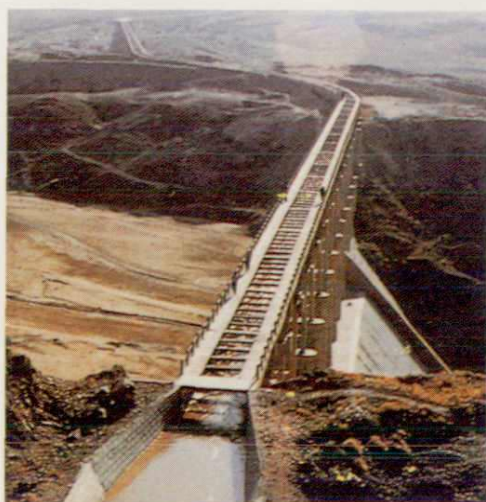
山西省大禹渡提水 灌溉工程上水管
