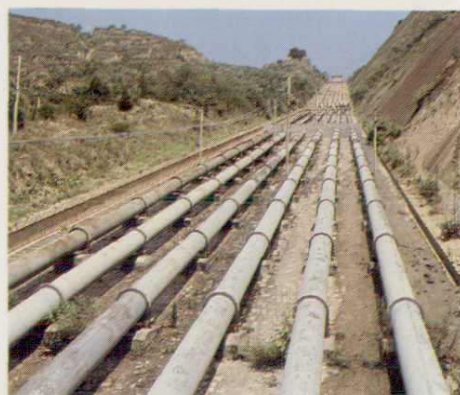
山西省大禹渡提水 灌溉工程上水管
