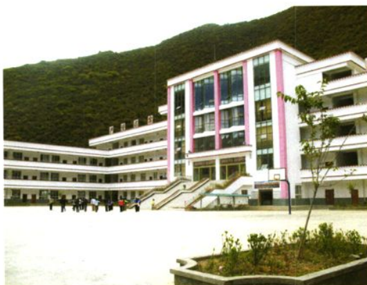
县中学教学楼
