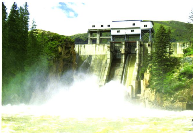
瓦其拉水电站取水枢纽
