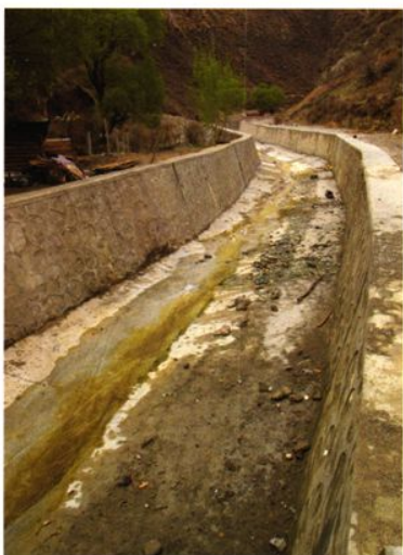
磨坊沟小流域水土流失治理工程
