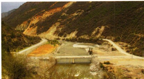
甘（孜）白（玉）公路219段改造工程
