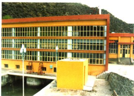
麻通水电站主厂房
