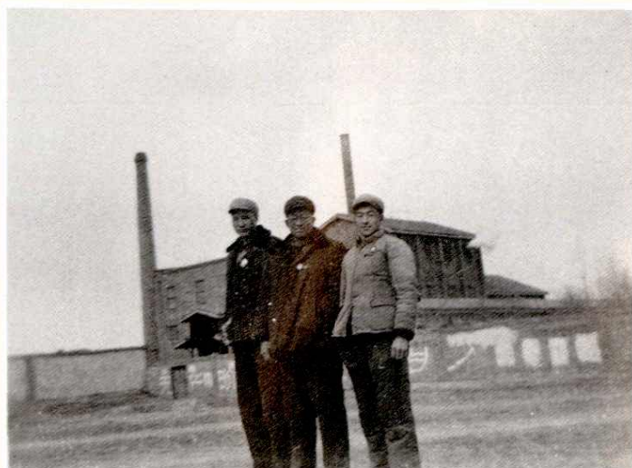
张掖南龙王庙电厂(装机容 量 2500 千瓦,1958 年 10 月第一 台机组投产发电)
