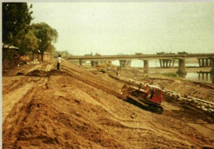
1989 年市浑河治河办施工的浑河桥下游右岸护坡工程正在施工中。
