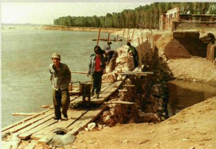
1988 年市浑河治河办施工的浑河八三护岸工程正在施工中。
