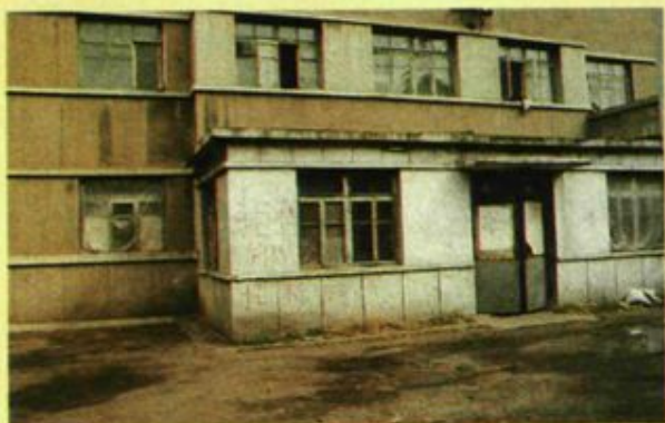
市浑河河道管理所 1982 年 10 月借用“市水文站”办公楼办公。
