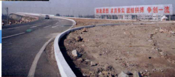
长兴公路大桥
