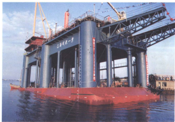
公司施工的辽海试采平台
