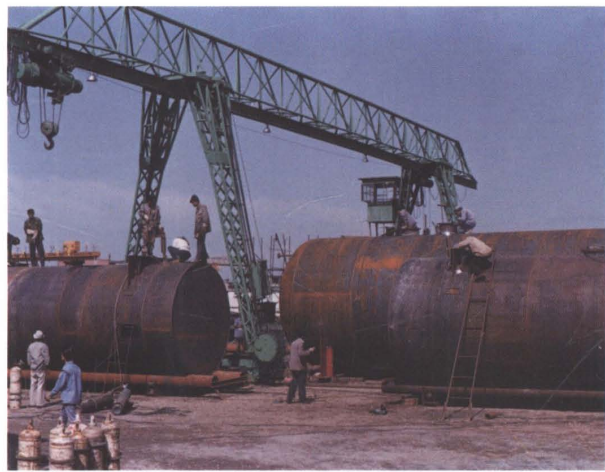
公司的附属企业施工现场
