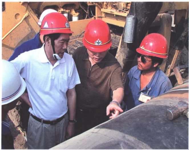
2002年7月，局长王革（左二）到公司西气东输施工现场检查指导工作
