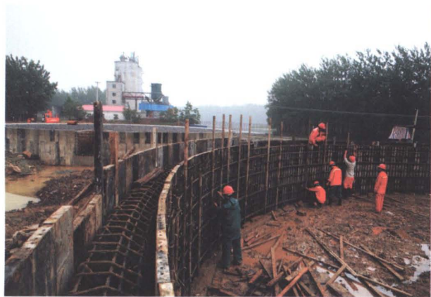
公司施工的大型油罐基础工程
