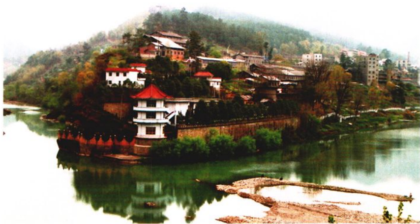
2000年5月竣工的日产2万立方米的县自来水厂
