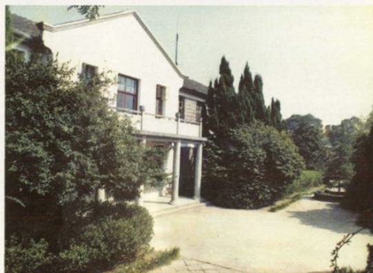
蒋堂校园办公楼
