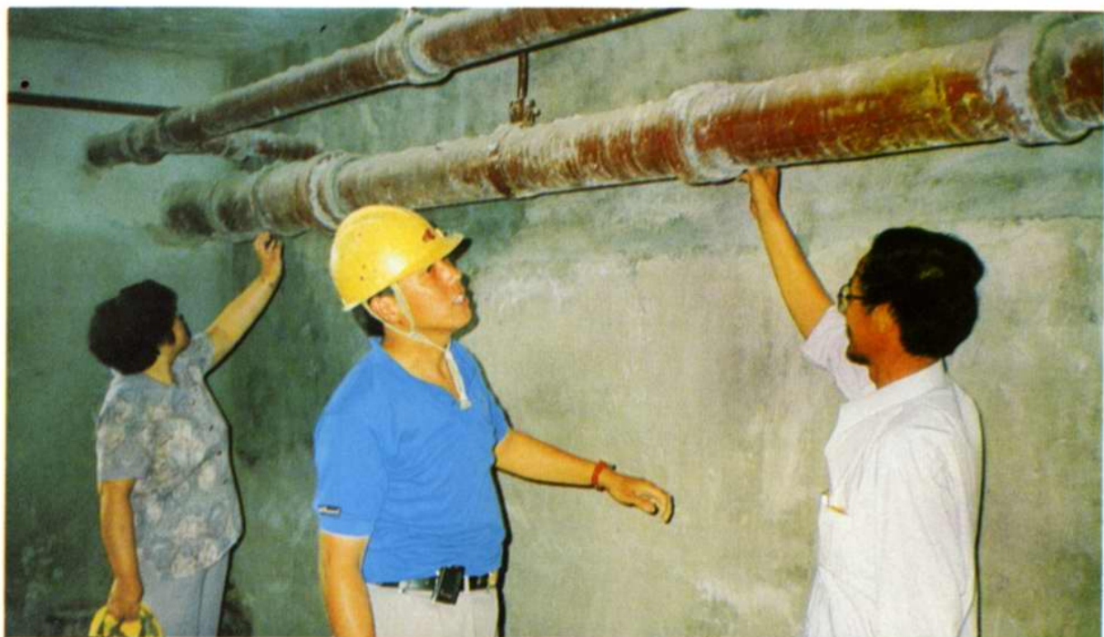
上图 暖卫专业监督员配合参加结构核查,进行管道安装 质量检查。
