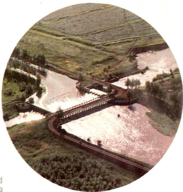
灌区立体交叉工程
