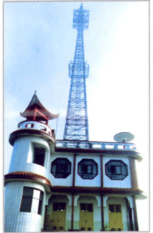
移动通信基站 ▶
