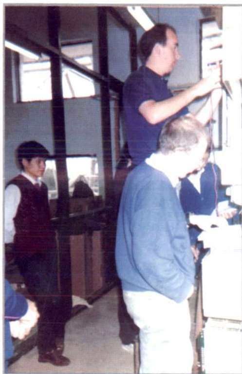
摩托罗拉公司的工程技术人员在通信基站施工现场 ▶
