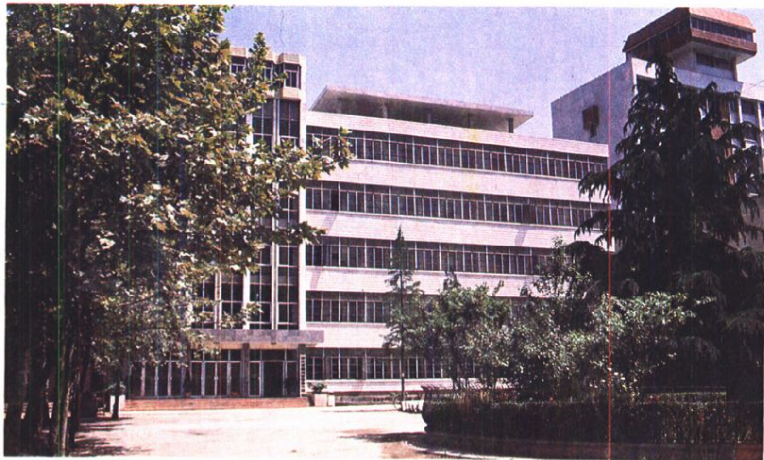
公司机关办公大楼
