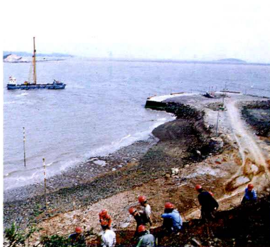
▲ 漩门二期围涂工程施工现场
