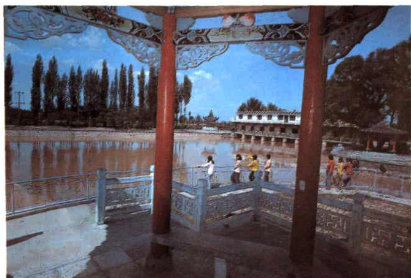
唐徕渠渠首工程景观
