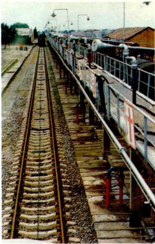
库内铁路接卸栈桥
