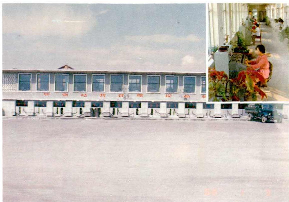
皇后园油库粘油电子付油设施
