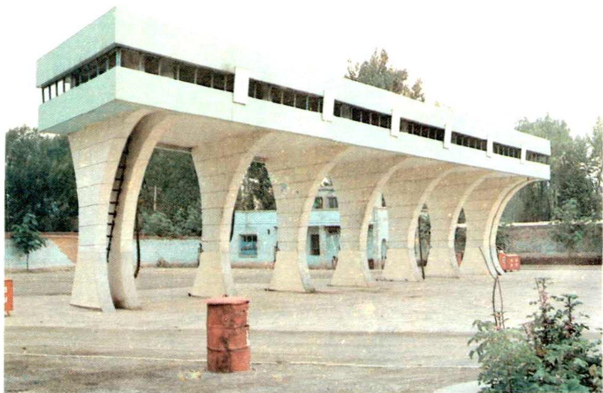
北郊区公司（桥式付油设施）
