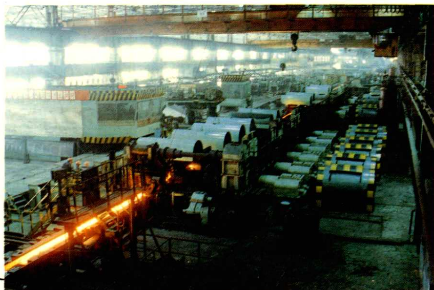
型钢分厂生产全景。▶
