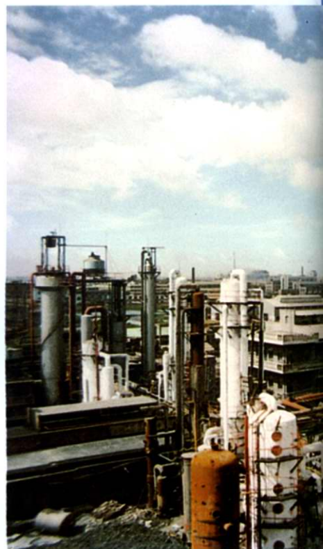
吴淞化工总厂化肥厂
