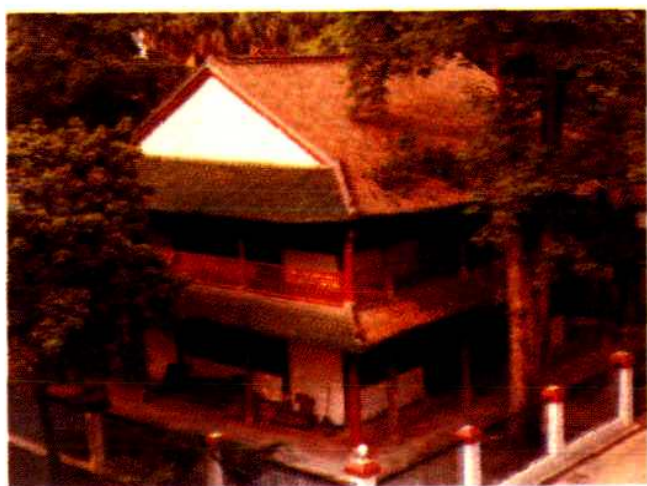
红楼（广东贡院仅存的明远楼 建于1684年）
