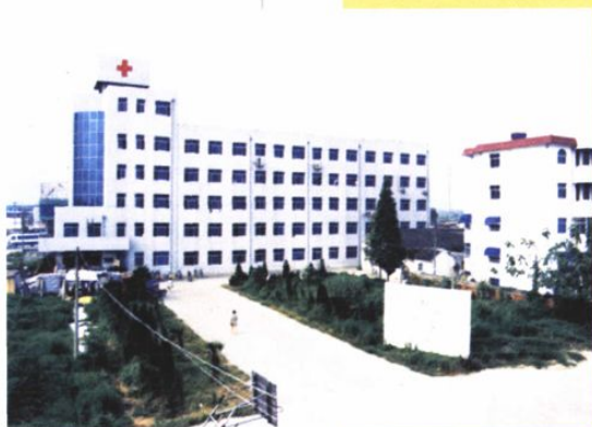
▲ 安丰中心卫生院病房大楼
