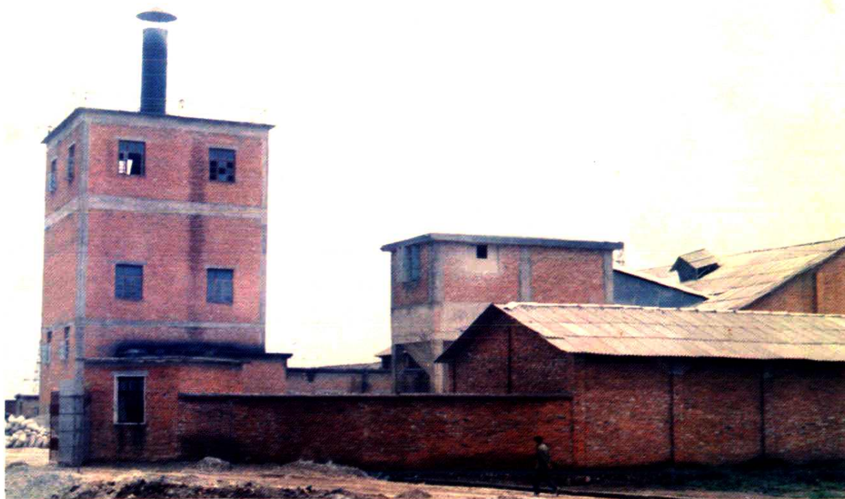
经营开发公司烧白厂全景
