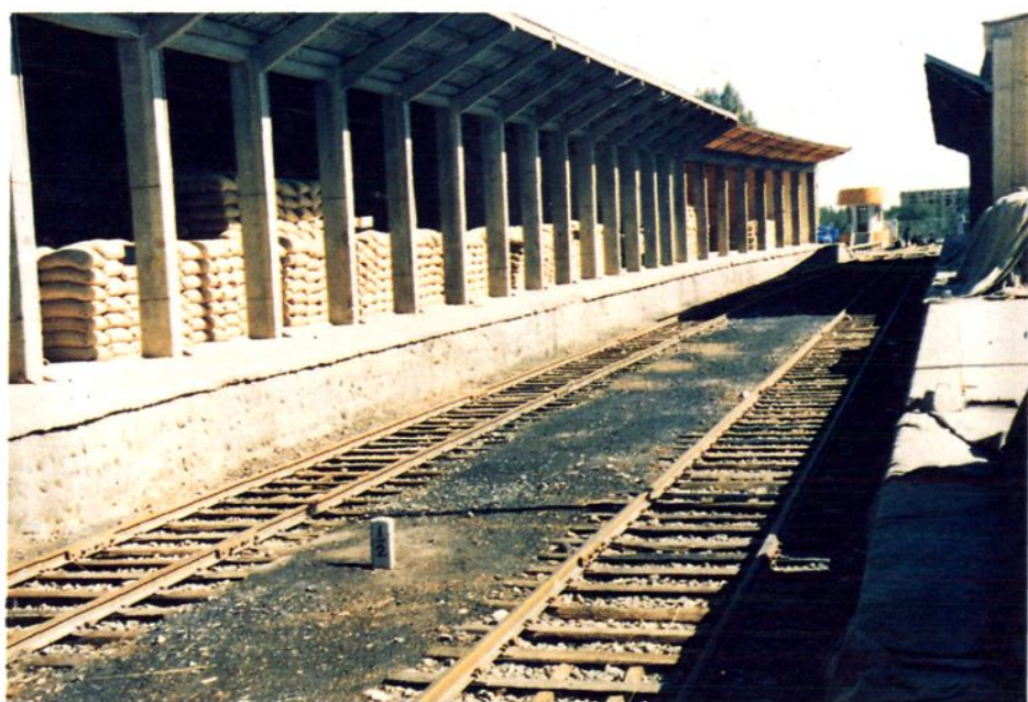
酒泉贮运站铁路专用线一角
