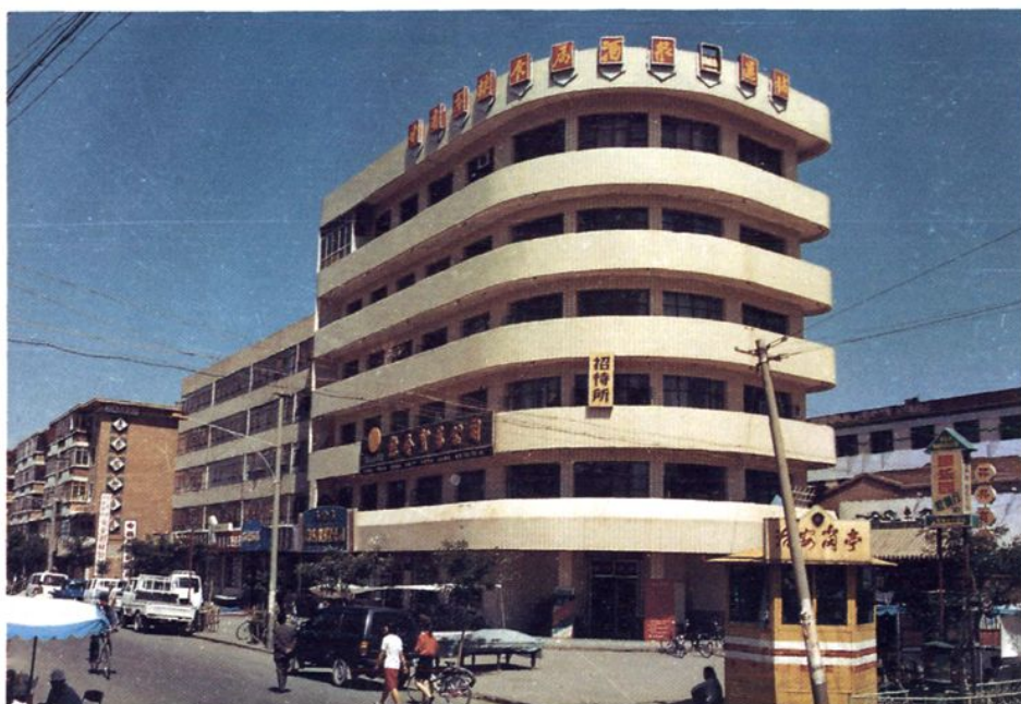
酒泉贮运站综合贸易公司综合楼
