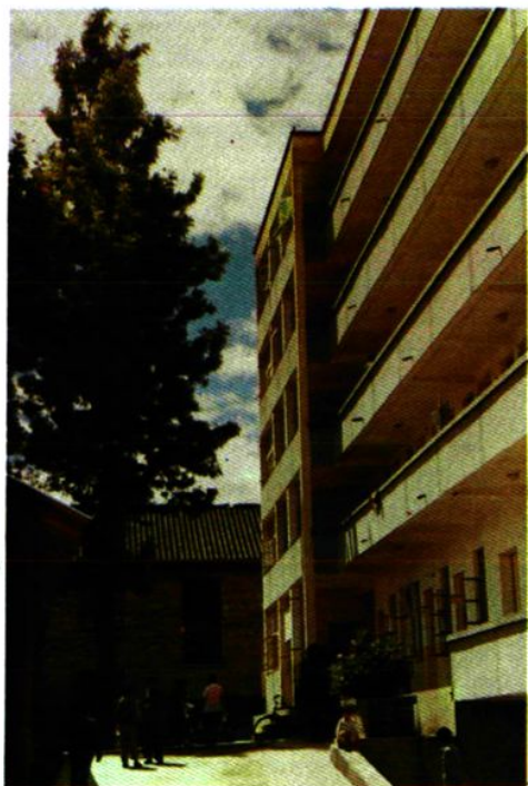
市医院门诊楼
