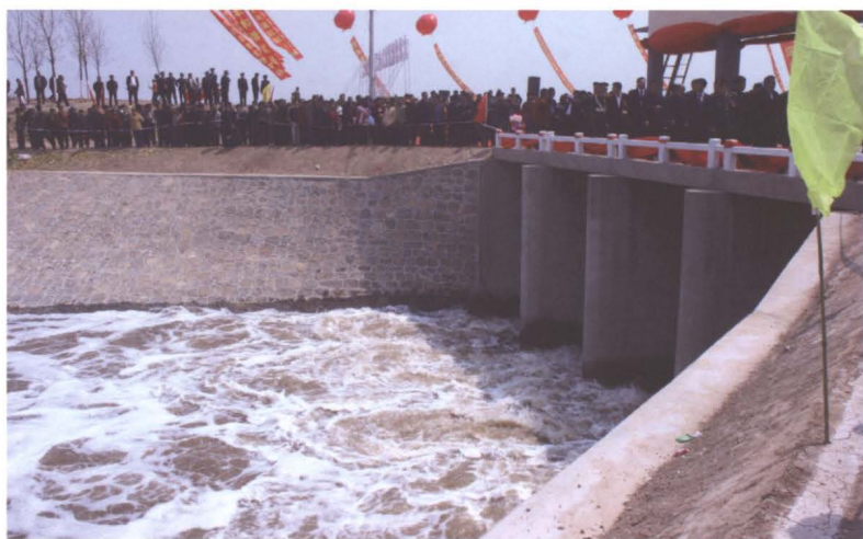
调蓄水工程开闸放水
