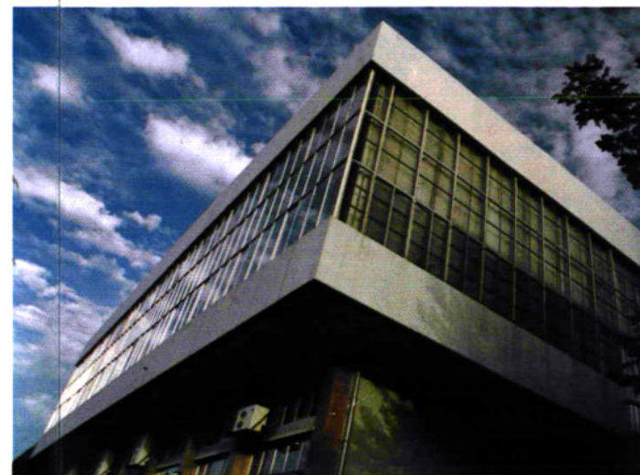
矿务局安全楼。
