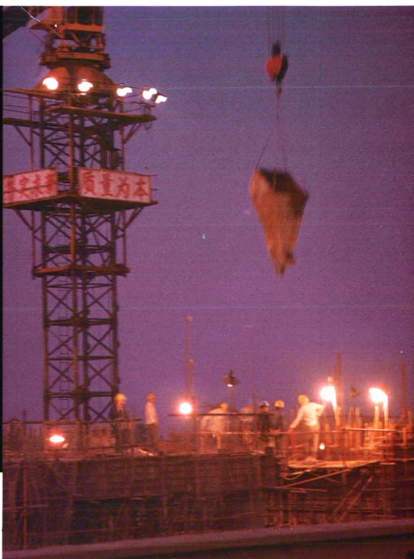
建井工程处施工现场。
