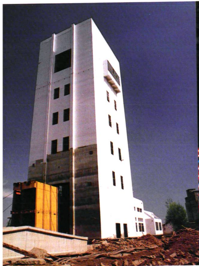
查庄煤矿新扩建的副井井塔。
