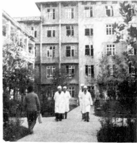
平昌县人民医院住院部
