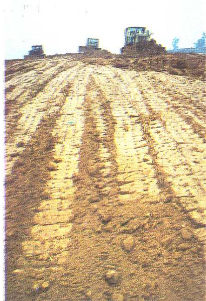
涪陵地区水电基建队在苏家湾站场施工中
