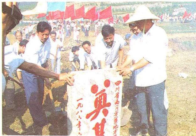
四川省、重庆市、涪陵地区、南桐矿区、南川县有关领导为万南地方铁路开工奠基
