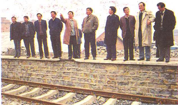
省、市、地政府和有关部门领导视察万南地方铁路施工现场
