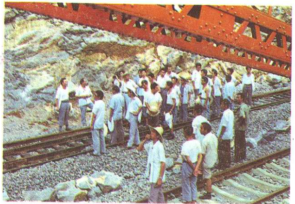
南川县委、人大、政府、政协领导视察万南铁路建设工地
