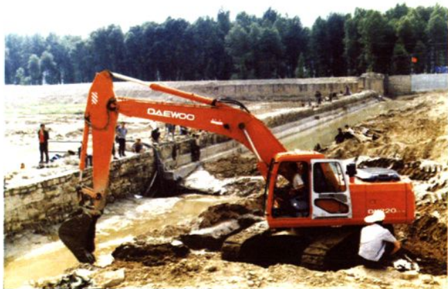
正在施工中的汾河上游滚水坝
