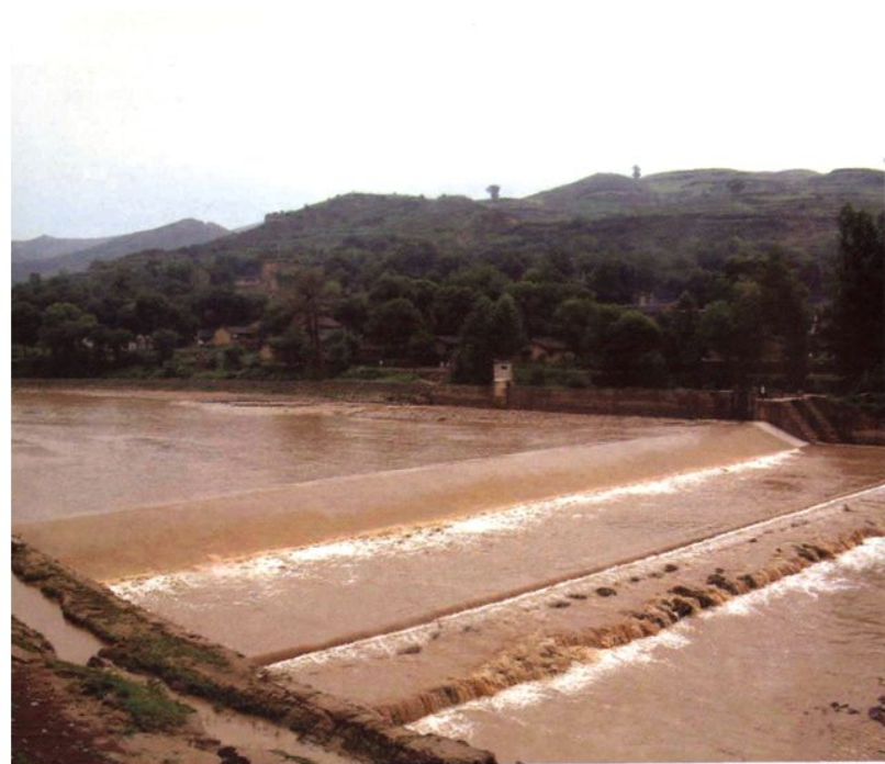
位于汾河上游宁武县境内的宁化堡滚水坝
