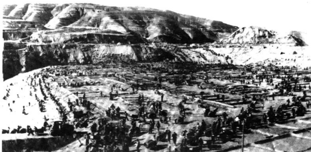
汾河水库大坝施工场景 (1958年)
