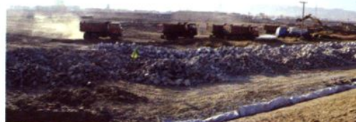
施工中的汾河景区北延伸工程(2005年12月)
