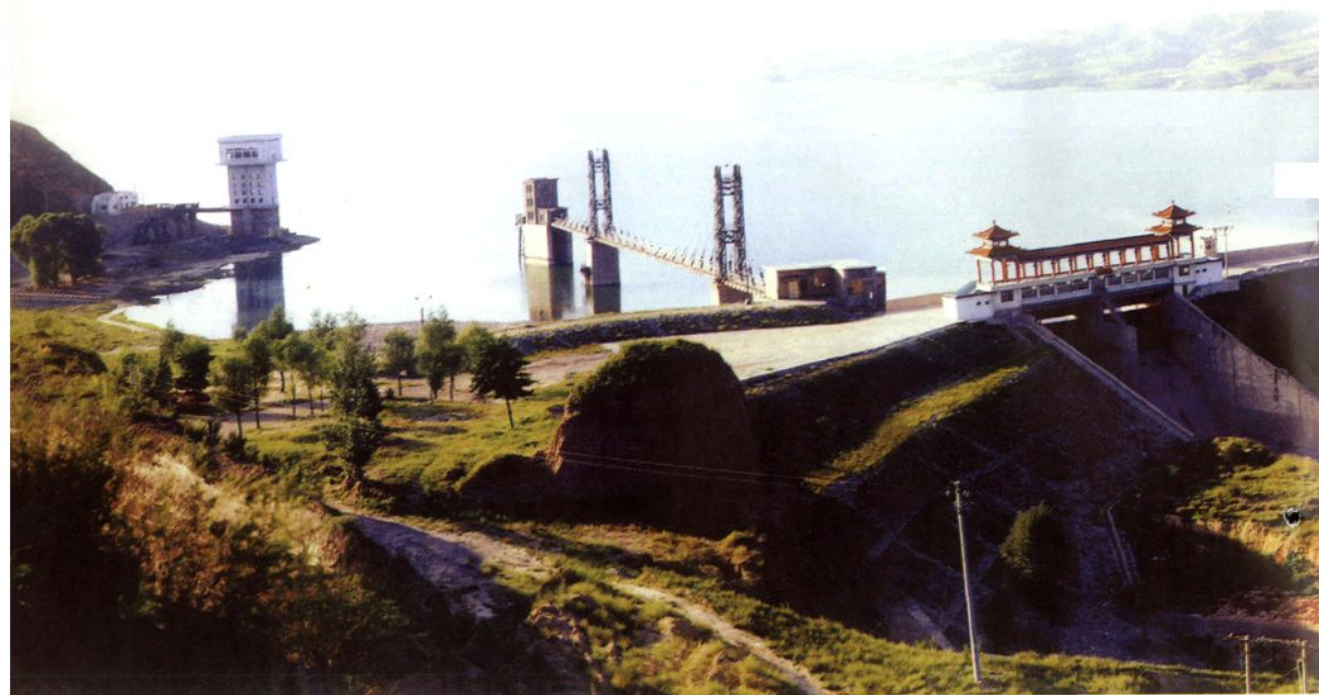
雄伟壮观的汾河水库枢纽工程。经过加固改建后的枢纽由拦河大坝、输水隧洞、泄洪排沙隧洞、溢洪道和水电站组成。
