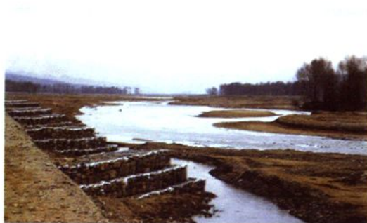
汾河上游河段的丁坝工程
