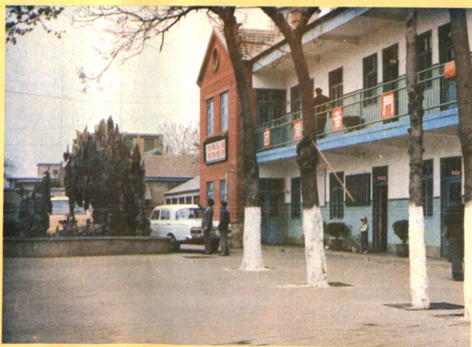
市木材公司办公楼
