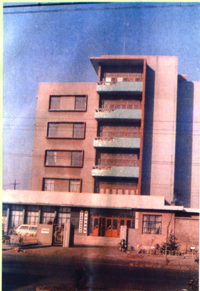
枣庄市物资局办公大楼
