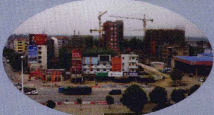
建设中的沙洋（2009年摄于洪岭大道中段）
